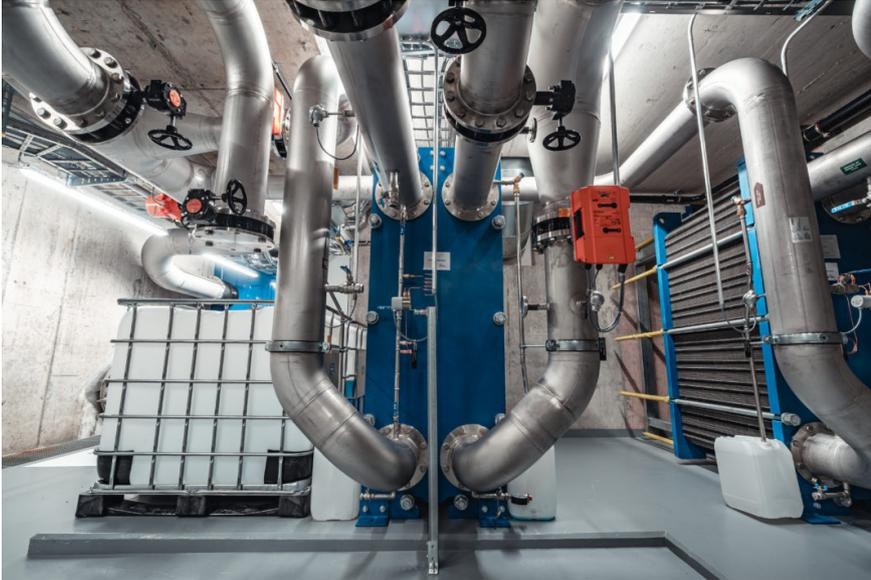
Die ersten Leitungen des Anergienetzes des Energieverbundes Jona (EZL) wurden 2018 verlegt. Der Durchmesser der Hauptleitung ab der ARA beträgt 45 cm. Im ersten Ausbauschritt wurden etwas mehr als 1000 Trassemeter verbaut. Die Installationen für die Wärmeengewinnung aus dem gereinigten Abwasser wurden im Herbst 2019 verbaut. Zusammen mit der HTB-Ingenieure AG (Planergemeinschaft) wurden die baulichen Massnahmen in der ARA und den Werkleitungsbau durchgeführt.
