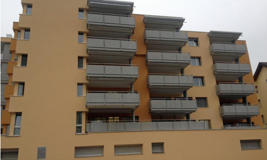
Das bestehende MFH mit 16 Alterswohnungen, einer Arzt- und einer Zahnarztpraxis wurde im MINERGIE®-Standard saniert. Neben einer komplett neuen Gebäudehülle mit Aussenisolation und Minergie-Fenster, wurde eine kontrollierte Wohnraumlüftung eingebaut. Auf dem Flachdach sind zwei Lüftungszentralen in eigenen Dachaufbauten aus Holz platziert worden. Die Küchen und Badezimmer wurden komplett erneuert. Die bestehende Ölheizung wurde durch eine neue Gasheizzentrale mit zwei Gaskessel ersetzt.
